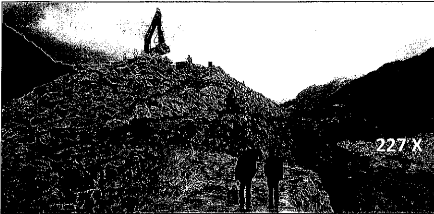
Digue frontale de Taconnaz, en cours de rehaussement.
