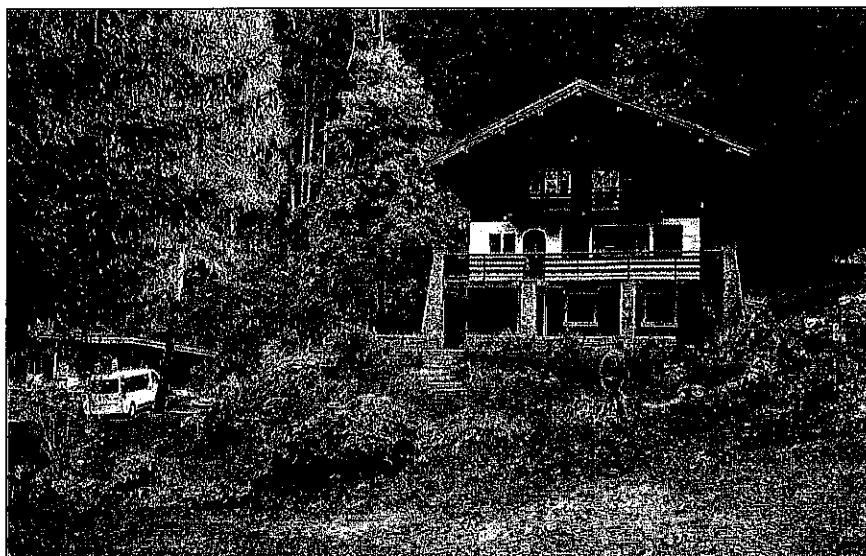
Chalets situés en rive droite de l'avalanche du Rocheray
