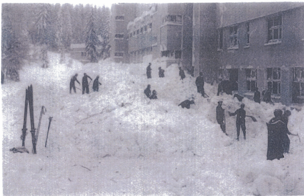
PERIMETRE DE L'ARVE - COMMUNE DE PASSY - Le Sanatorium de Guébriant immédiatement après l'avalanche de neige du 31 Janvier 1942 C). GIGUET (gestionnaire du Sana) du 2 Février 1942
