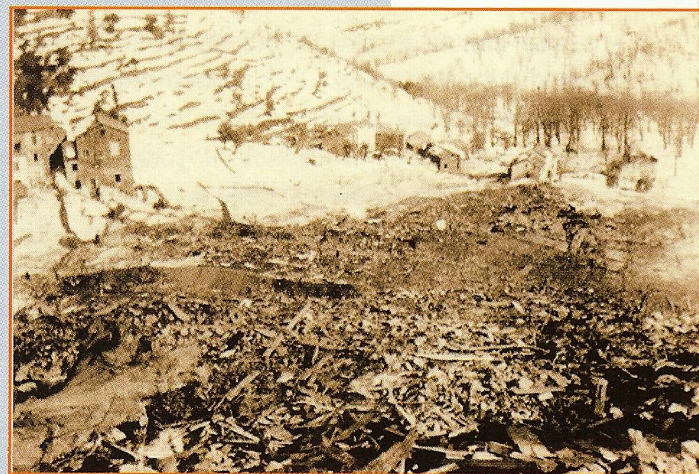
Dépôt de l'avalanche et dégâts aux maisons.
